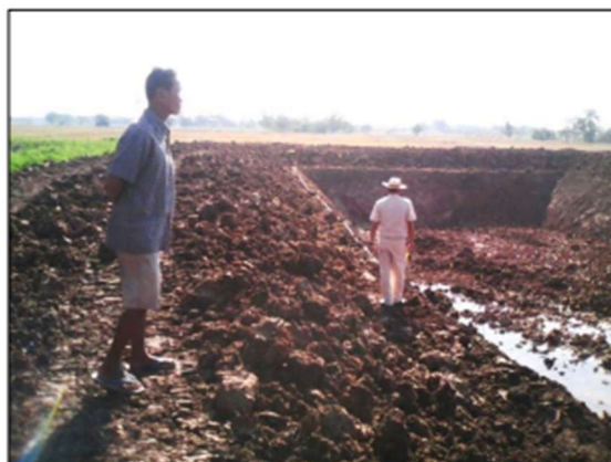
ดำเนินการขุดสระน้ำ
